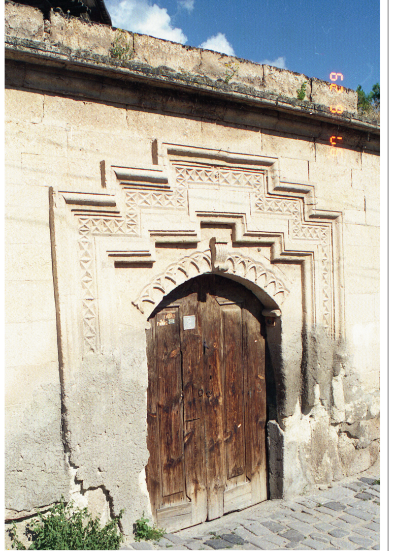
Resim 4A, 4b Sokağa bakan avlu duvarı ve Avlu Cümle Kapısı 1997
