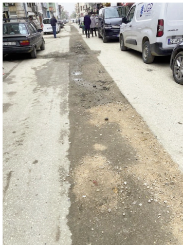
Su borusu döşeme
