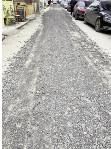
Su borusu döşeme
