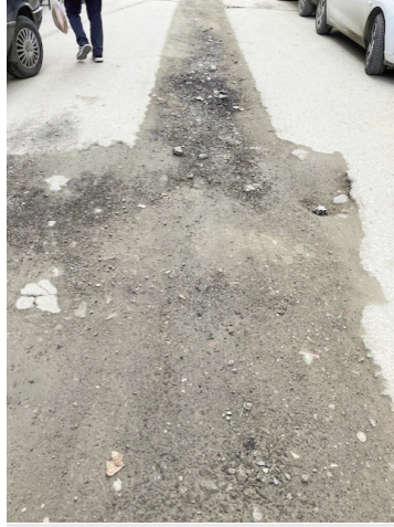
Su borusu döşeme
